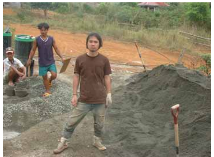
セメント作業中の家入貴裕兄
