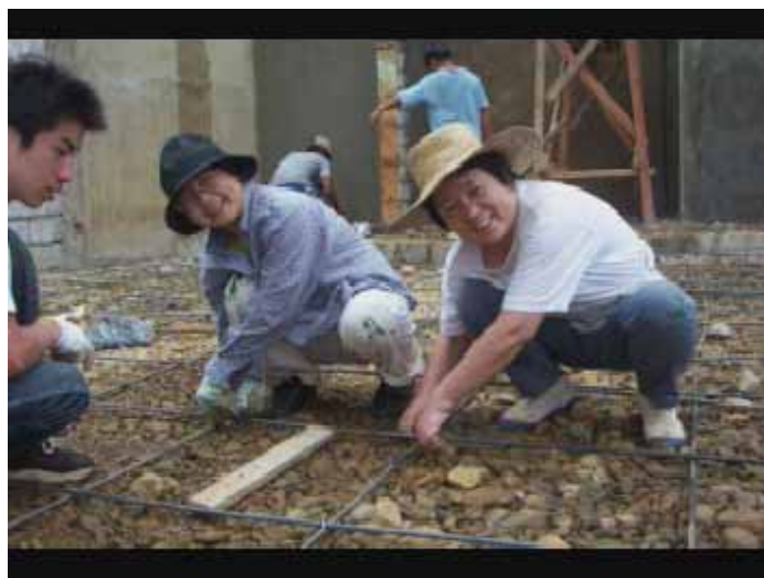
鉄筋留め作業中の左から野田兄、簗田紘子姉そして簗田智佐子姉
