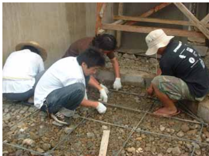
礼拝堂の床のセメント打ち準備
